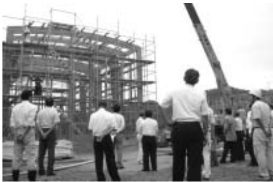
建設中の(仮)海の里会館(阿納尻)
